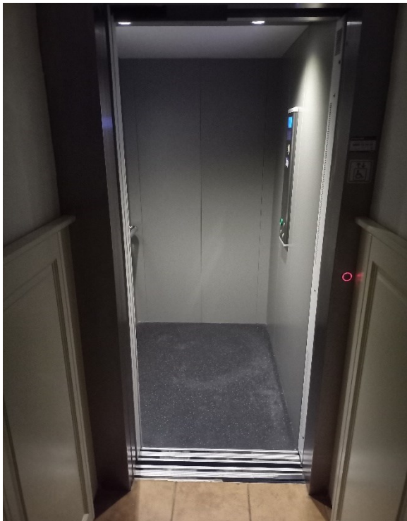
Obr.č.5: Výťah dobudovaný v objekte kaštiela
