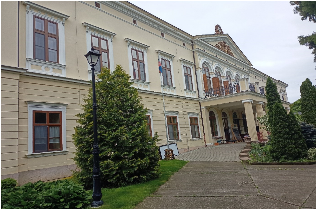
Obr.č.1: Objekt zariadenia – predná časť
