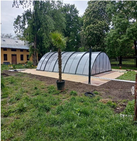
Obr.č.23:Vonkajší krytý bazén
