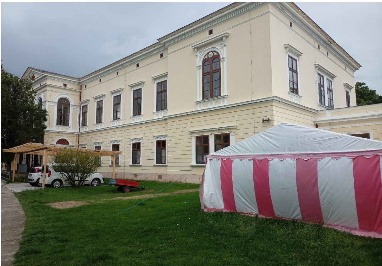
Obr.č.2: Objekt zariadenia - zadná časť
